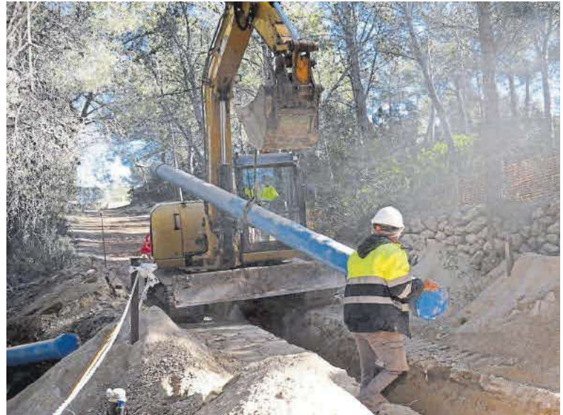
Inicio de las obras para llevar agua desalada a Cala Llonga.
