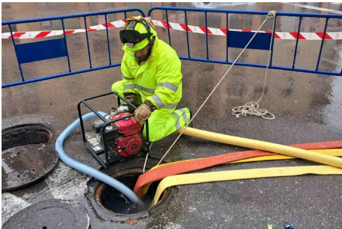
Efectivo del Infocam trabajando en las zonas inundadas de Talavera
