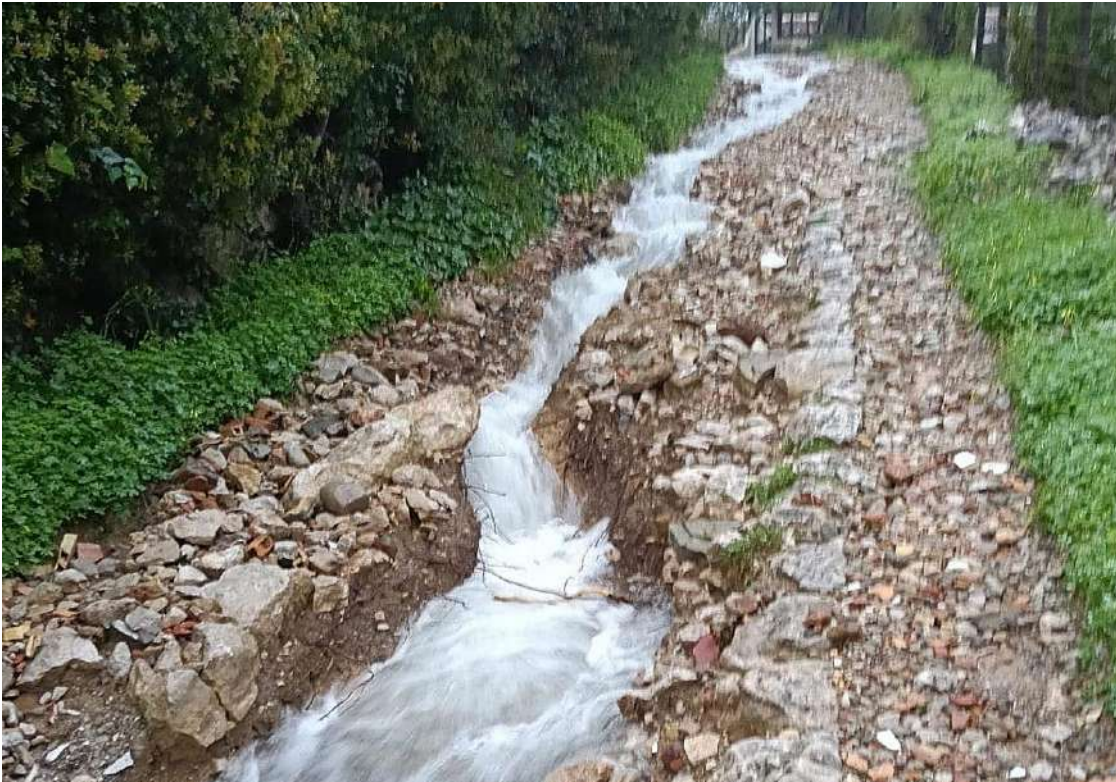
Daños en la calzada romana de Ubrique a Benaocaz. Imágenes de los socavones. la voz
