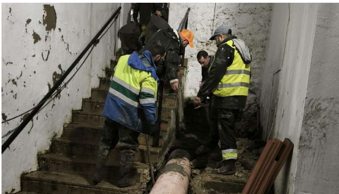
Operarios de Aguas de Ubrique, trabajando en el bypass en la plaza del Colilla
