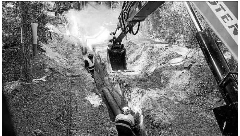
El proyecto contempla la implantación de nuevas infraestructuras para mejorar la eficiencia y la capacidad del sistema. Foto: AYTO SANTA EULÀRIA
