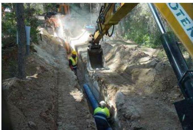
Operarios trabajando en las obras | Foto: Ayuntamiento de Santa Eulària des Riu
