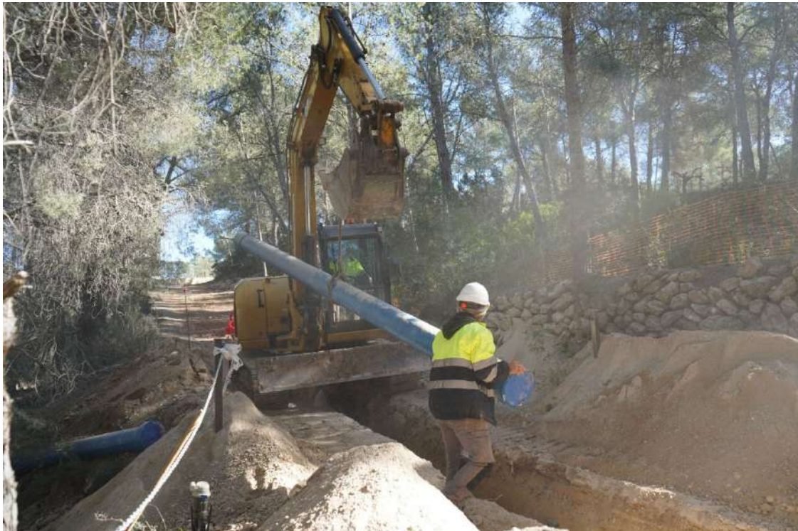
Iniaron las obras para llevar agua desalada a 1.200 abonados de Cala Llonga
