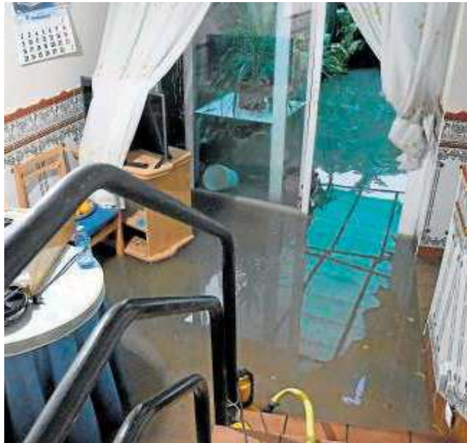
El patio y el cuarto de estar de una vivienda, anegados // ABC
